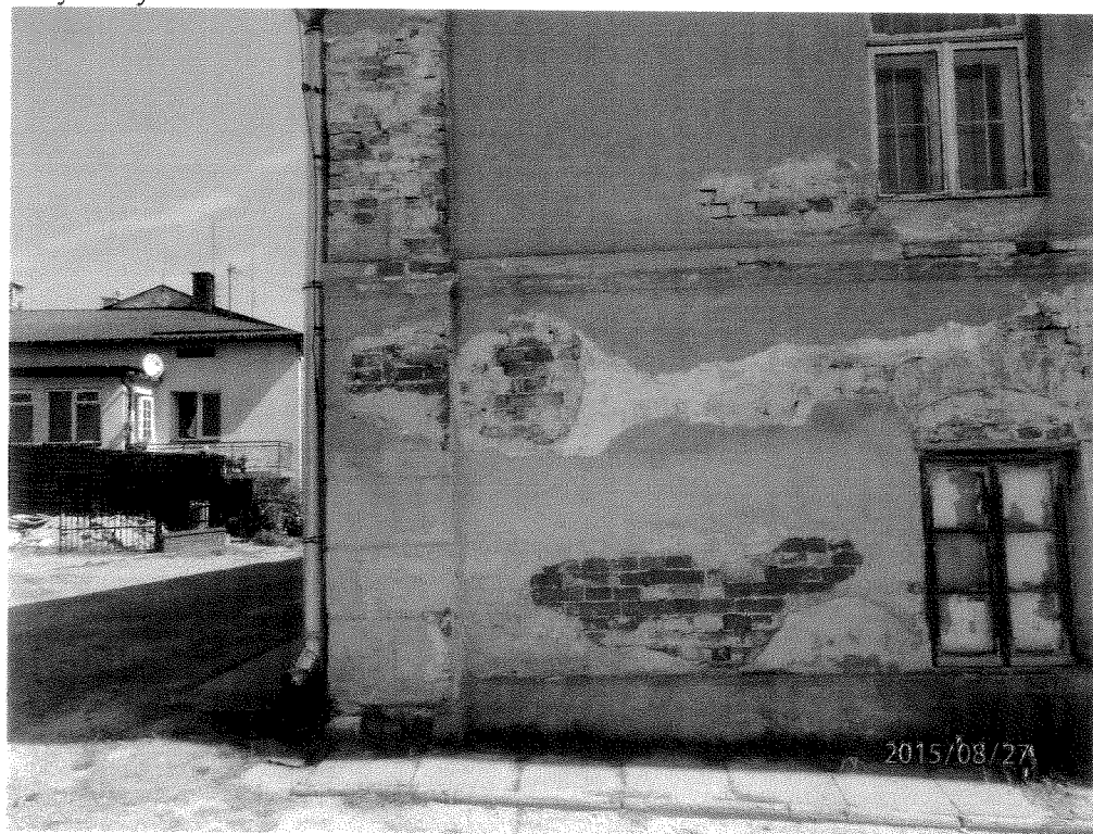
Fot. 19 Fragment elewacji zachodniej. Uszkodzenia gzymsów nad parterem i piętrem. Ubytki tynku.
