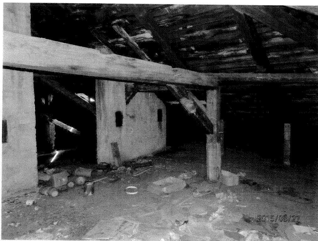
Fot. 47 Widok więzby ,skorodowane krokwie.
