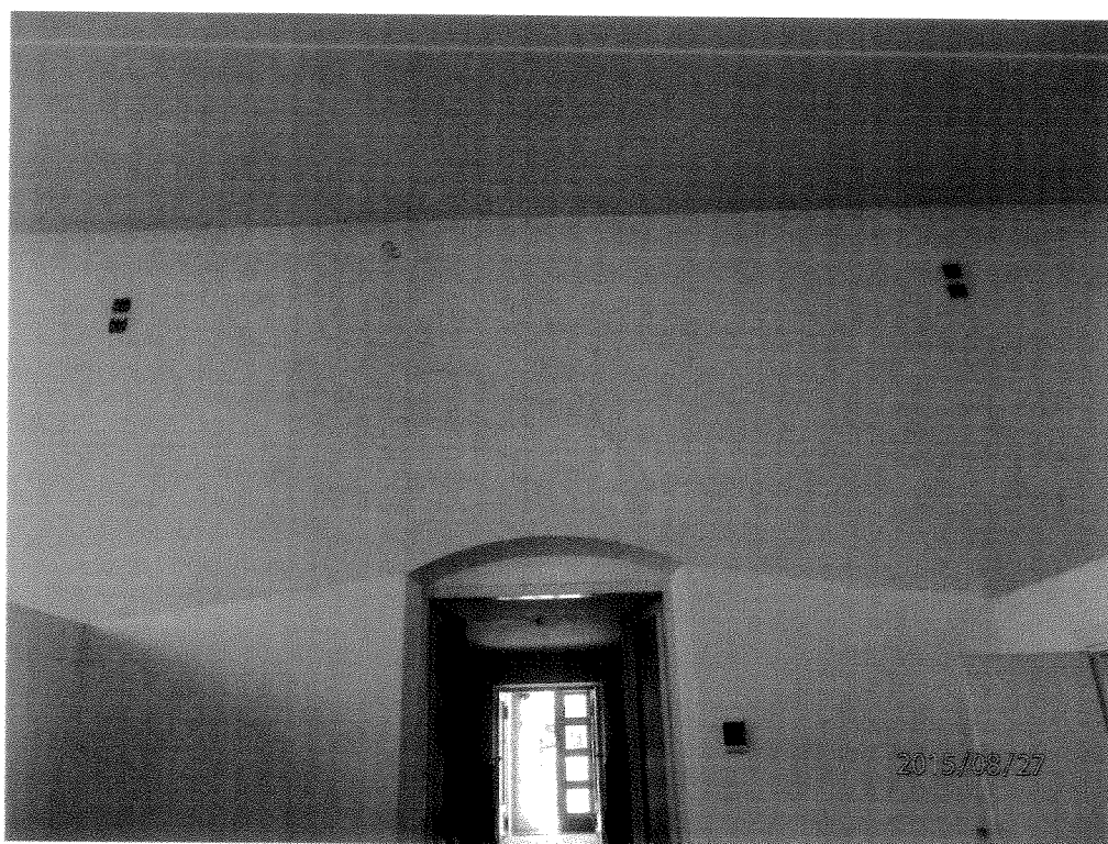
Fot.26 Rysy ukośne nad nadprożem wejścia sali głównej.
