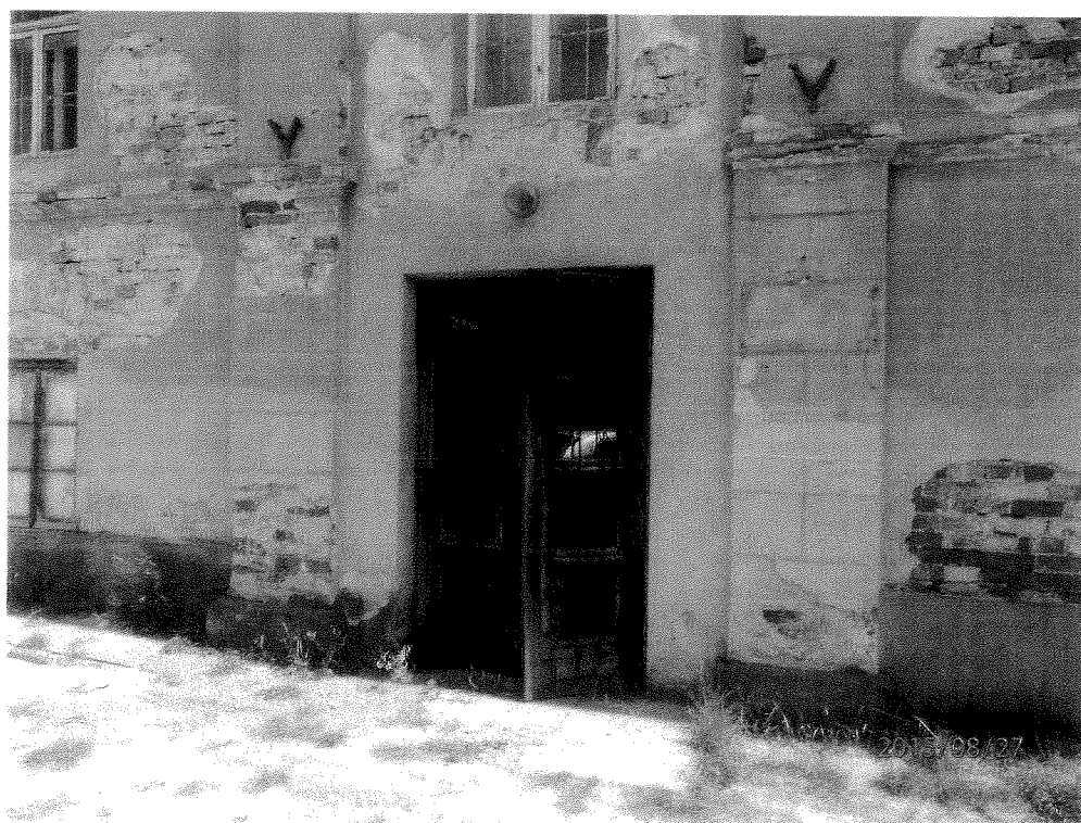
Fot.24 Elewacja zachodnia w części wejściowej. Uszkodzenia muru, ubytki, Zawilgocenia.
