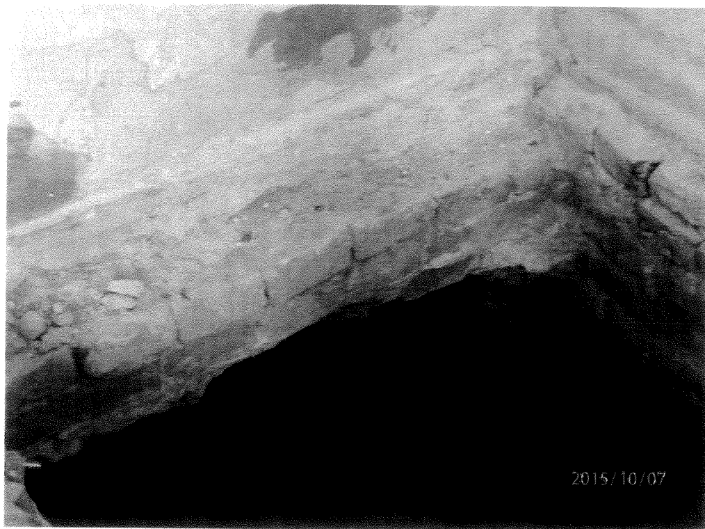
Fot. 26 Odkrywka fundamentu pod ścianą wewnętrzną z lewej strony holu.
