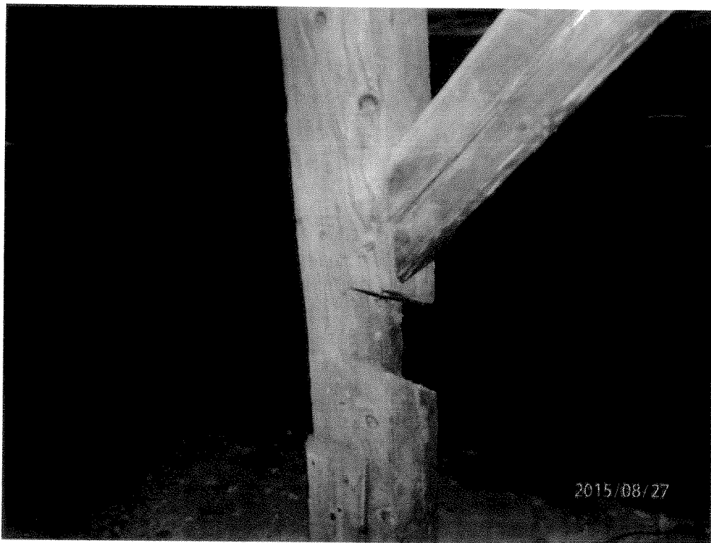
Fot. 49 Podcięty słupek konstrukcji dachu.
