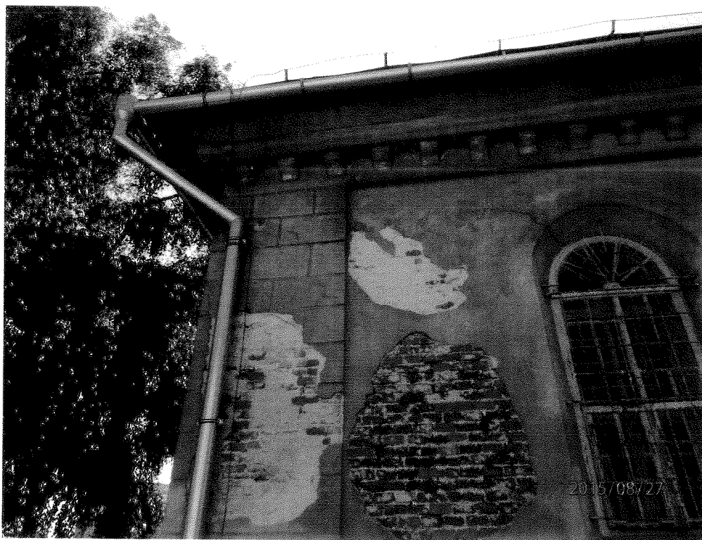
Fot.11 Fragment elewacji północnej. Ubytki tynku, rysy ukośne w narożu ściany i okna.
