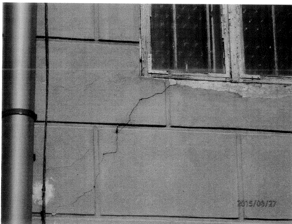
Fot. 4 Rysy ukośne pod oknem piętra na elewacji południowej.
