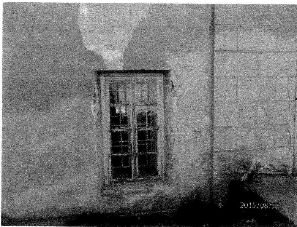
Fot. 17 Ubytki tynku, liczne rysy i zawilgocenia elewacji północnej.
