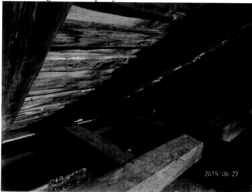
Fot.40 Zawilgocone deski pokrycia i krokwie.
