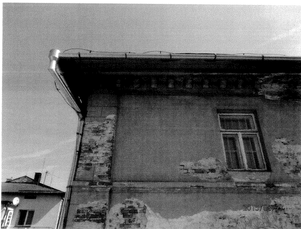
Fot. 19 Fragment elewacji zachodniej. Uszkodzenia gzymsów nad parterem i piętrem. Ubytki tynku.
