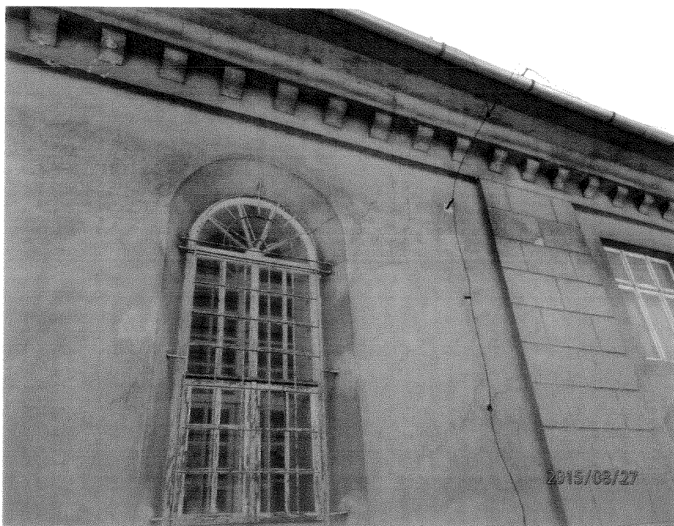
Fot. 14 Elewacja północna. Rysy pionowe gzymsu, rysy ukośne w nadprożu okna. Rysy w tynku.
