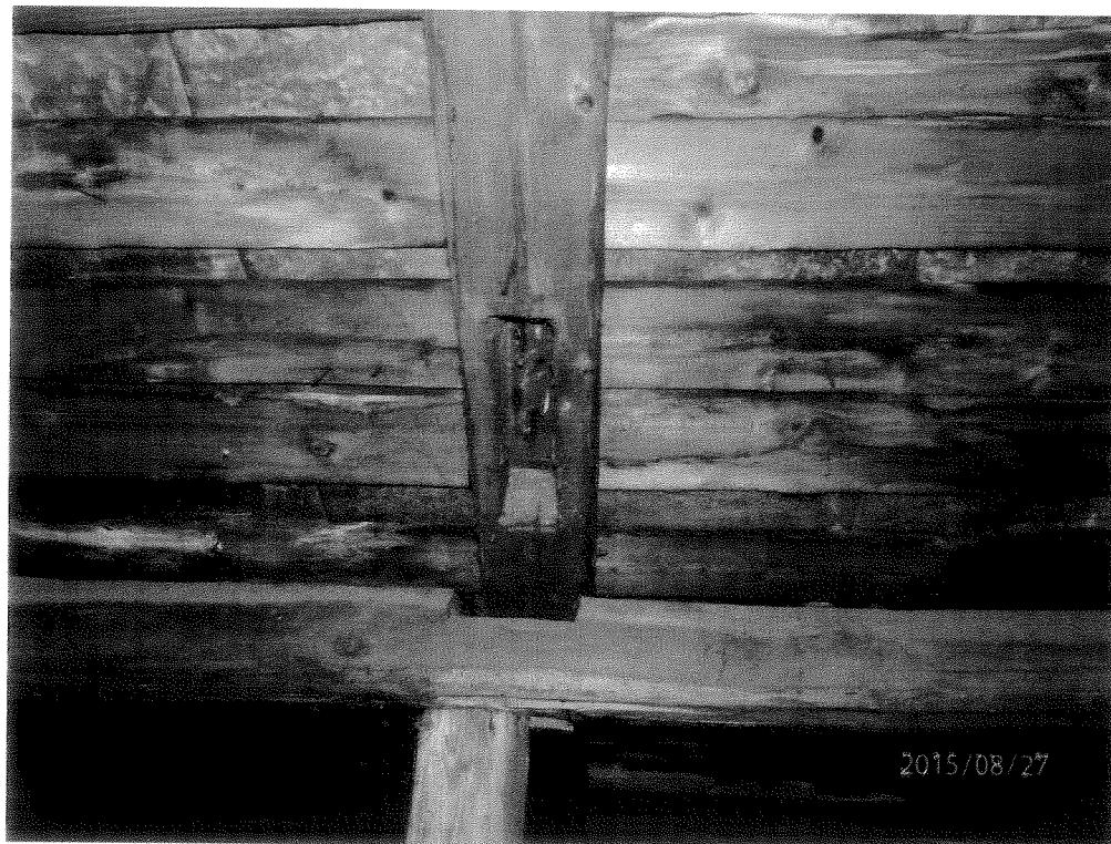
Fot.48 Ubytek krokwi, podcięta płatew.
