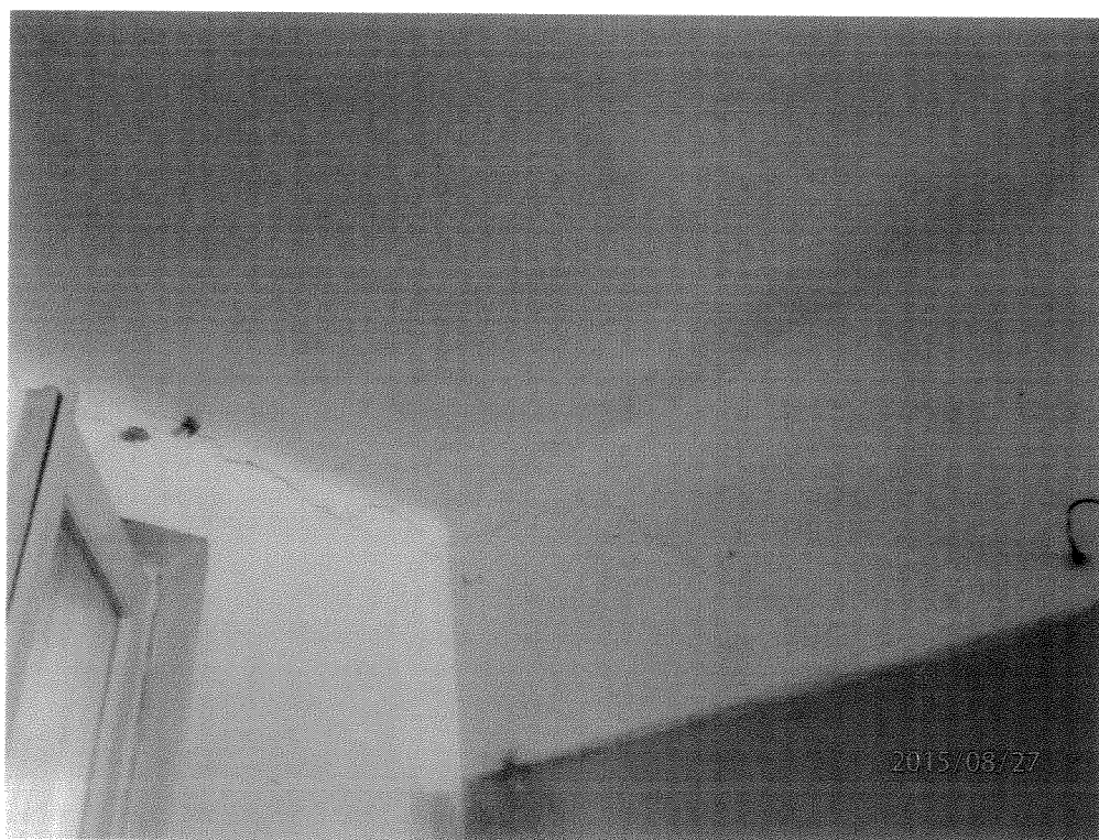
Fot. 33 Rysa nad wejściem do sali głównej przechodząca na ścianę z prawej strony holu.
