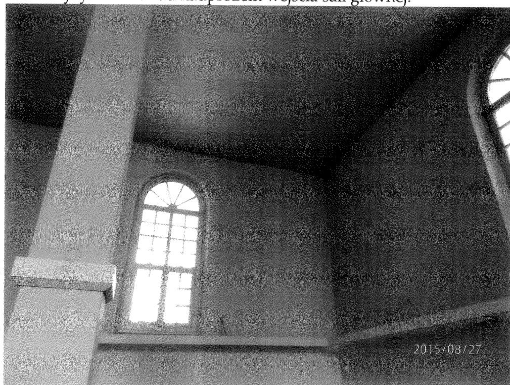
Fot. 27 Rysy ukośne nad oknem w ścianie północnej sali głównej.
