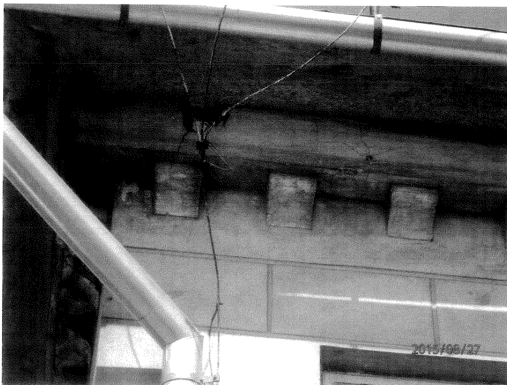
Fot. 3 Górna część fragmentu elewacji jak wyżej. Widoczne pęknięcia i zarysowania gzymsu.
