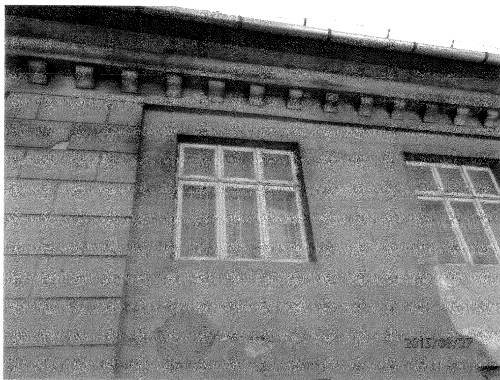
Fot. 16 Ubytki tynku i liczne rysy na elewacji północnej.
