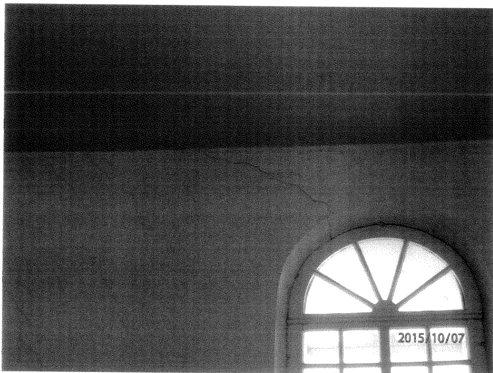
Fot. 28 Rysy ukośne pod stropem sali głównej i w nadprożu okna.
