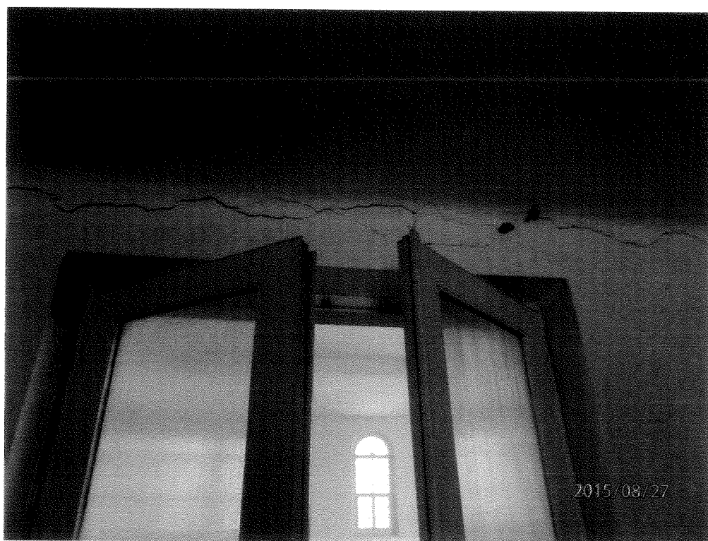
Fot.32 Rysa pozioma nad wejściem do sali głównej.
