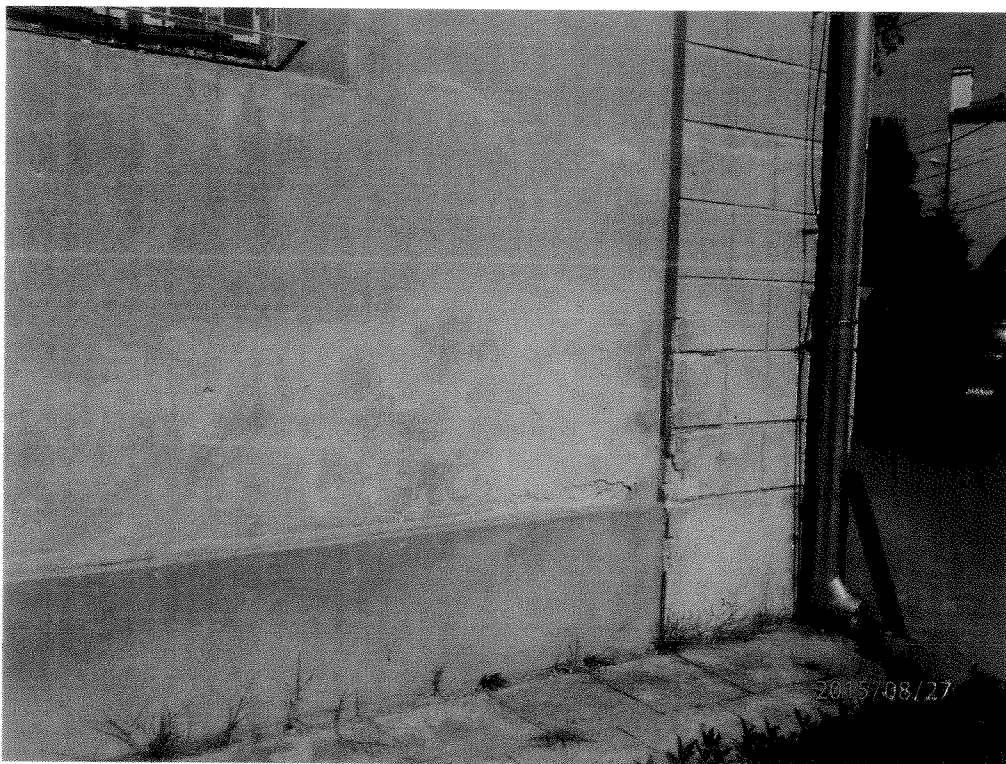
Fot.8 Dalszy fragment elewacji południowej. Zawilgocenia i uszkodzenia muru w pasie 2 m nad terenem.
