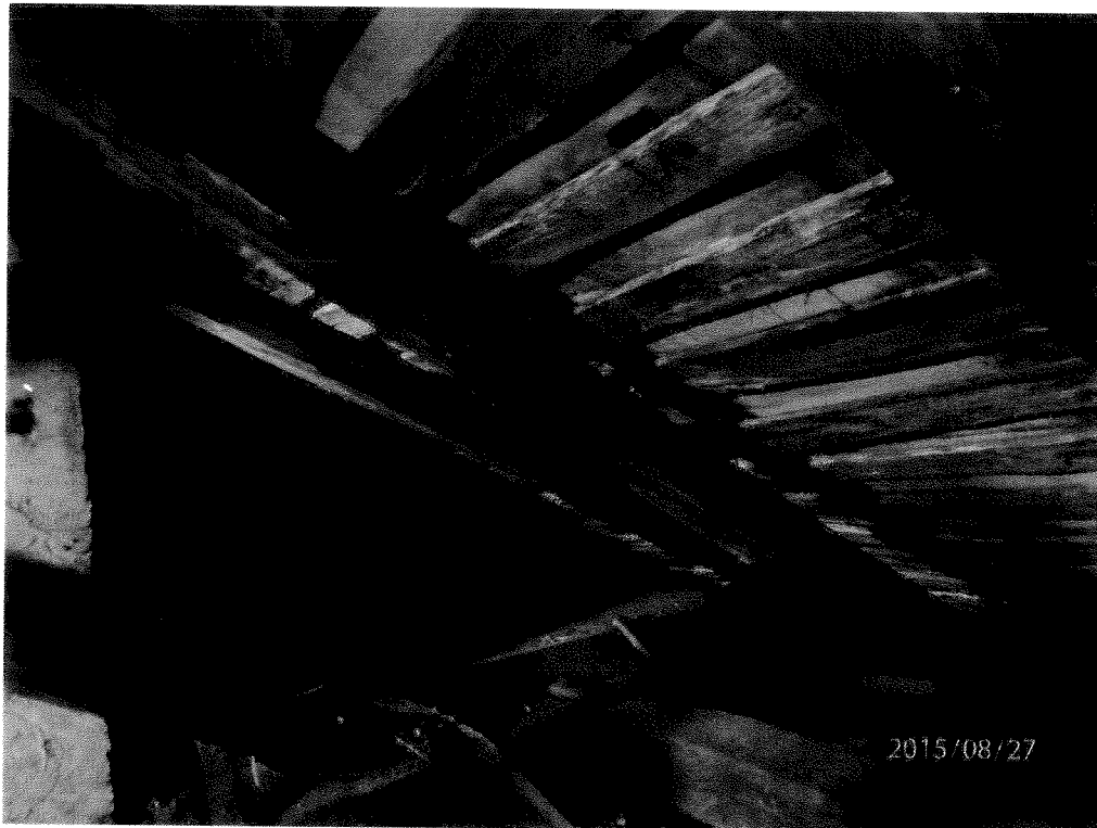
Fot.40 Zawilgocone deski pokrycia i krokwie.
