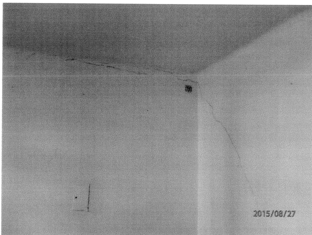
Fot.34 Rysa w narożu ścian pod stropem sali głównej.
