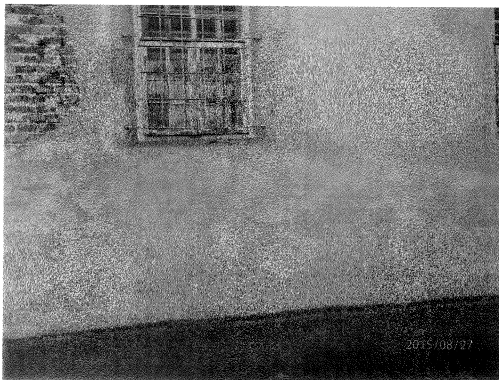
Fot.12 Fragment elewacji północnej. Rysy ukośne w narożach okien. Zawilgocenia muru.
