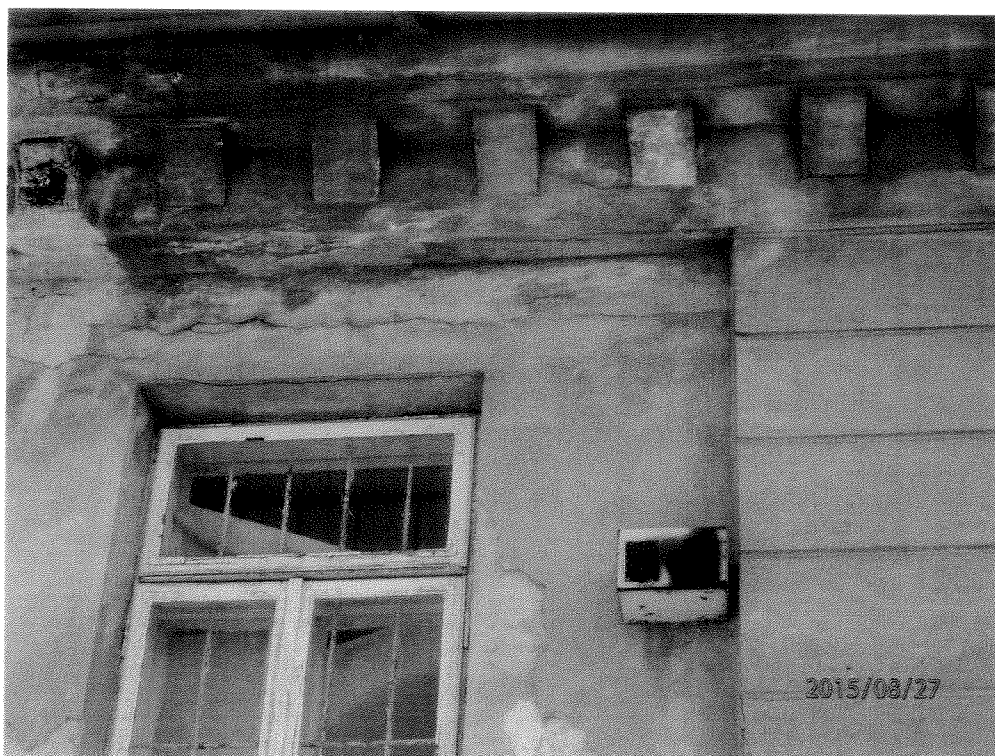
Fot. 23 Elewacja zachodnia. Rysa pozioma nad oknem piętra. Rysy ukośne i pionowe. Ubytki tynku .Zawilgocenia gzymsu.
