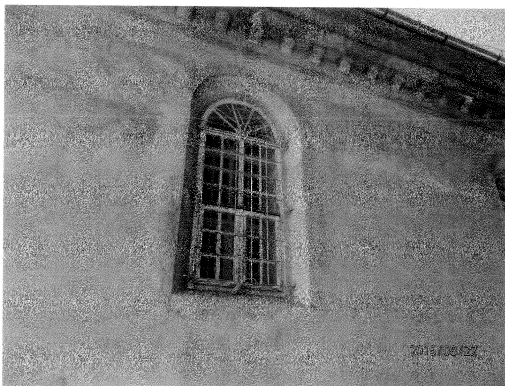
Fot. 9 Liczne rysy w tynku na elewacji wschodniej.
