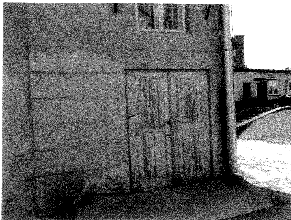
Fot. 18 Dalszy fragment elewacji północnej. Rysy ukośne pod oknem. Ubytki tynku i zawilgocenia.
