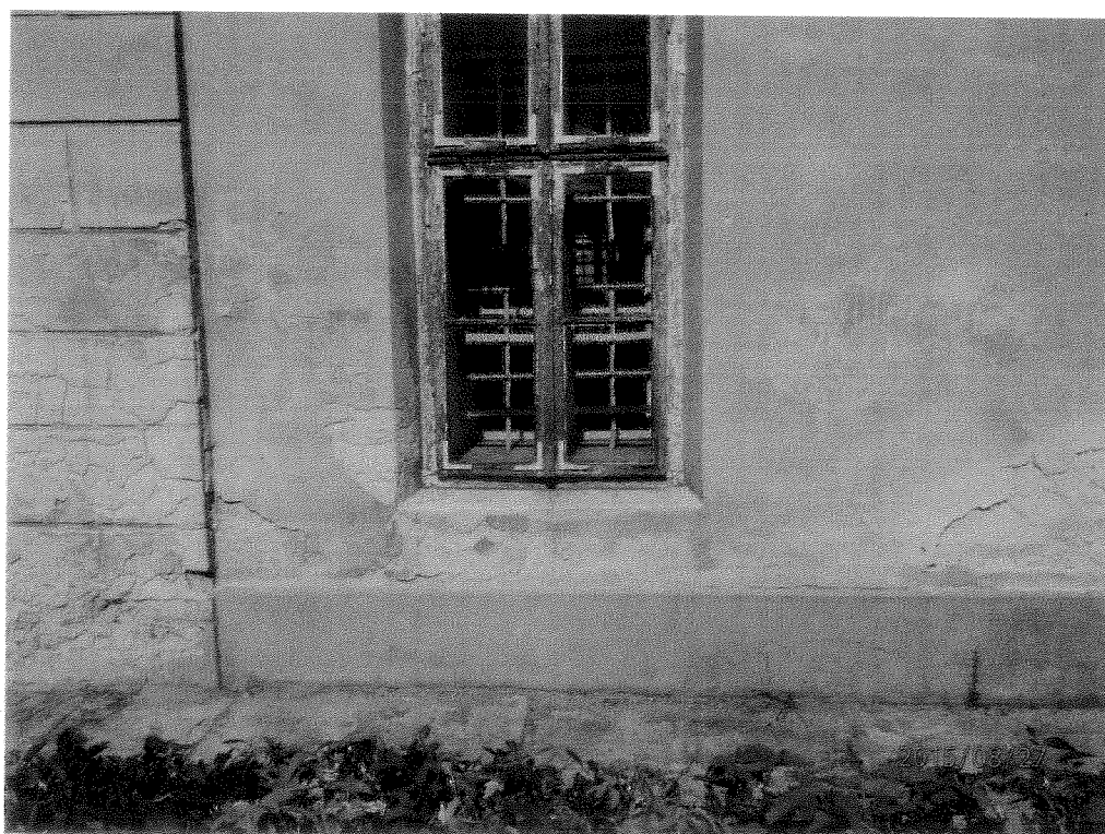
Fot. 5 Dalszy fragment elewacji południowej. Korozja tynku i zawilgocenia.
